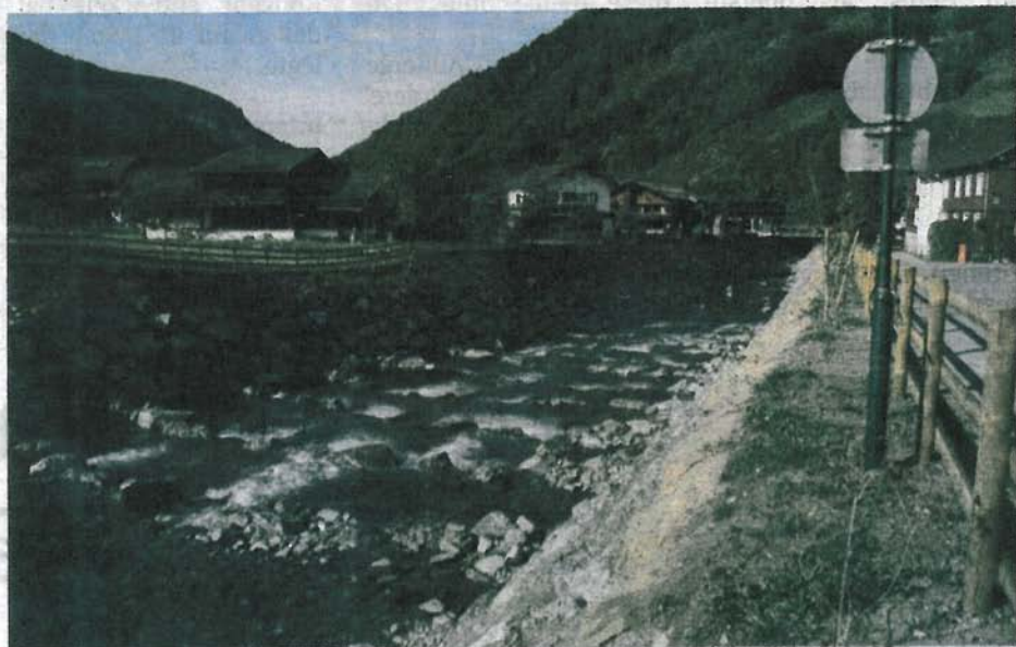
Fischpassierbare Riegelrampe im Mellenbach.
