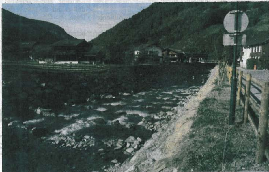
Fischpassierbare Riegelrampe im Mellenbach.
