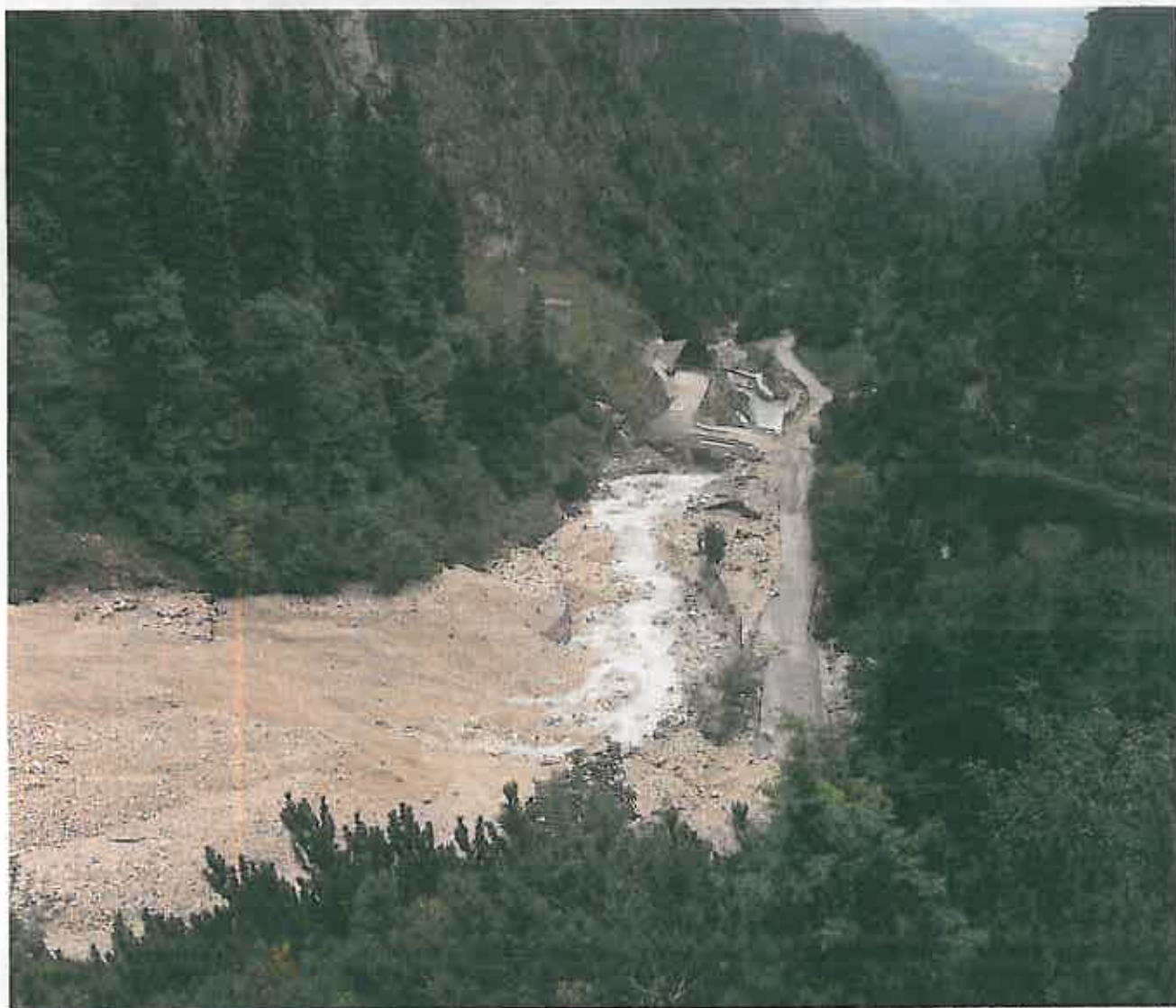
Bezahlt gemacht haben sich die Investitionen in den Trinkwasserstollen der Gemeinde Absam und der Stadtwerke Hall in Tirol GmbH (heute Tochter der Hall AG) im Halltal: Trotz Murenabgänge war die Trinkwasserversorgung der beiden Gemeinden im Juli nicht gefährdet. Fotos: Hall AG; Universität Innsbruck
